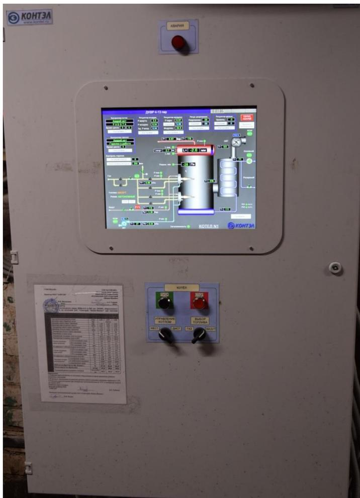
На лицевой панели щита управления котлоагрегатом расположены кнопки «Пуск/стоп».
